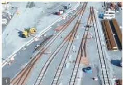
留置線跡を整備中。側走行する線を変更するための分岐器も設置されています。車両基地内のレールと架線柱。
