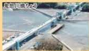
▲おおよそ1kmほど離れたところから見た鬼怒川横りょう。橋の中央部分が2月28日に完成しました。(写真日は2月28日撮影)
